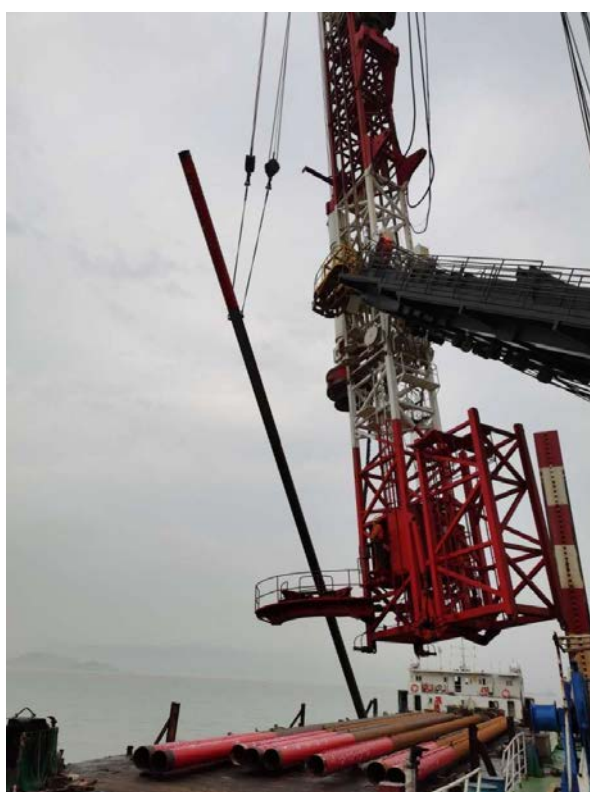
图 2.3.3-4 现场吊桩图
