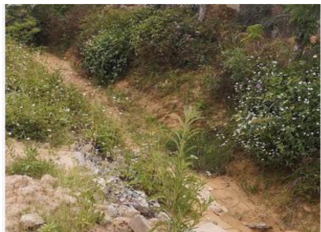
厂区外围排水沟
