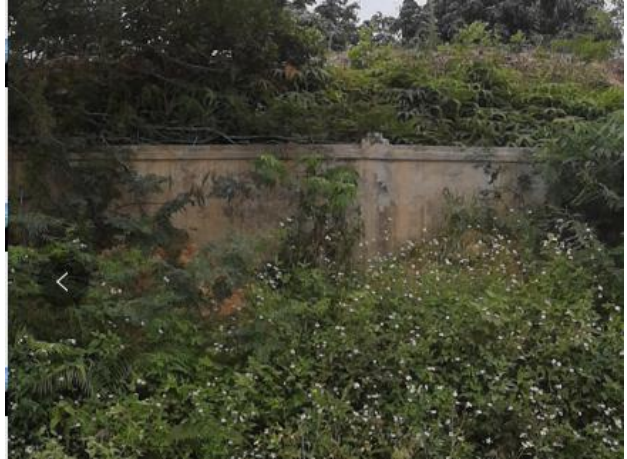
项目场地现状（厂区周边围墙拦挡）
