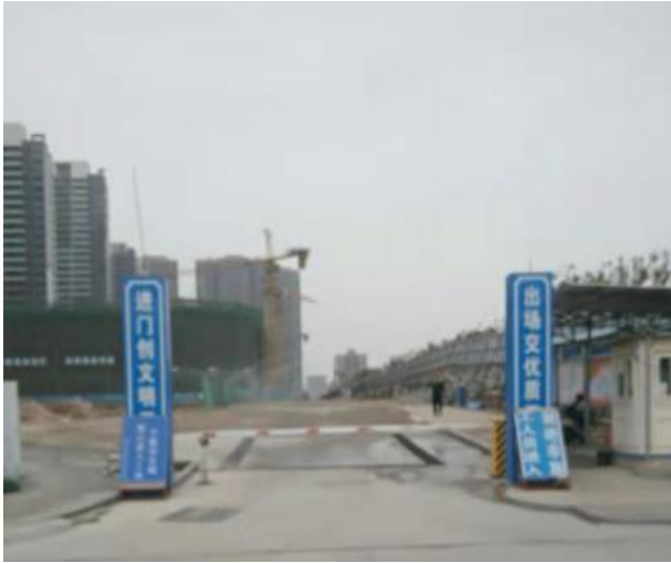
项目施工出入口
