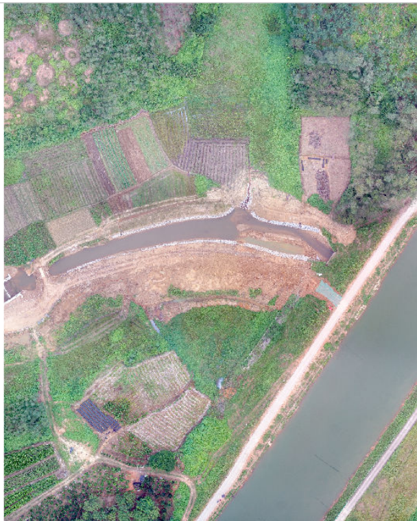
图 2-2.1 河道起点（整治中）
