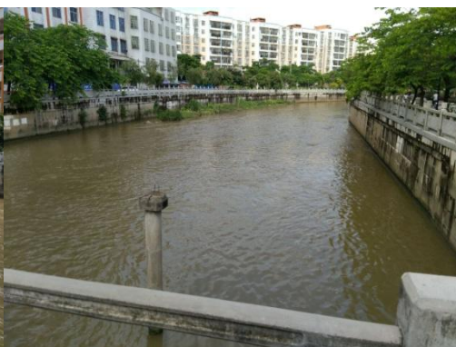
图 2.2-2 公园水闸下游堤岸
