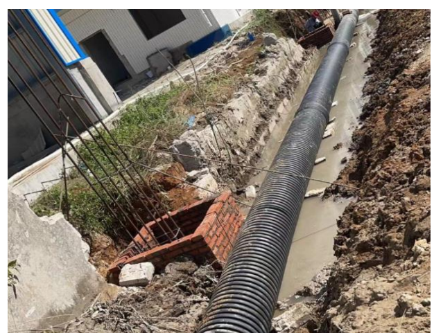
项目雨水管道敷设
