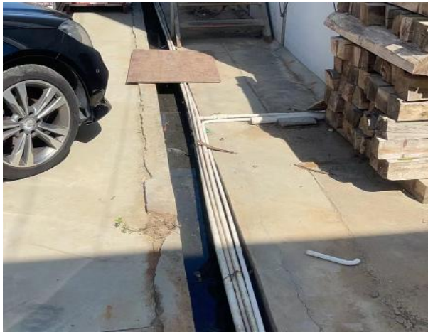
厂区内排水沟
