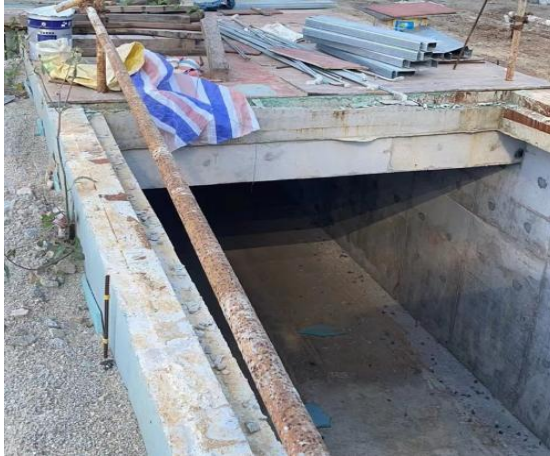
图 1 地下室基坑现场图
