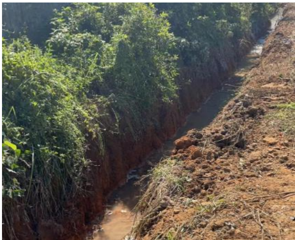
厂区外土质排水沟
