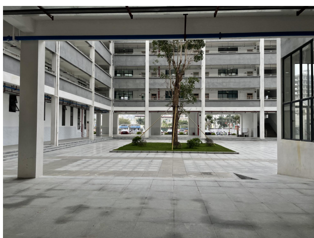
主体建筑现状
