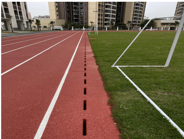
项目区排水沟现状
