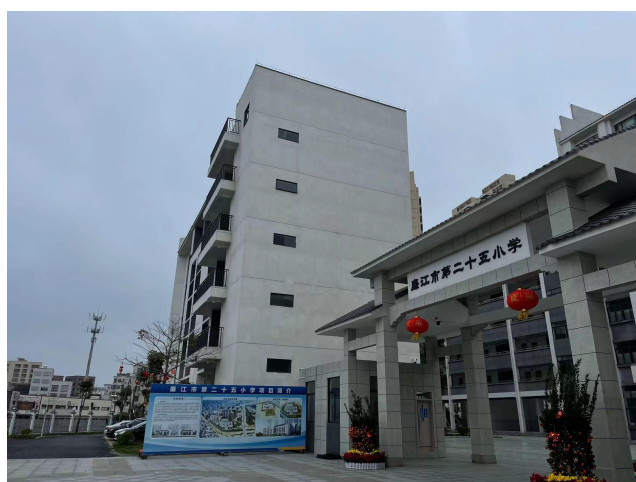
主体建筑现状
