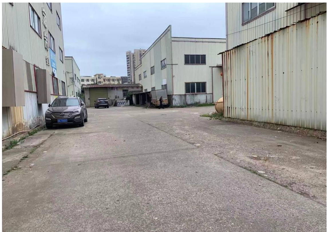
北地块项目建设区现状（二期）
