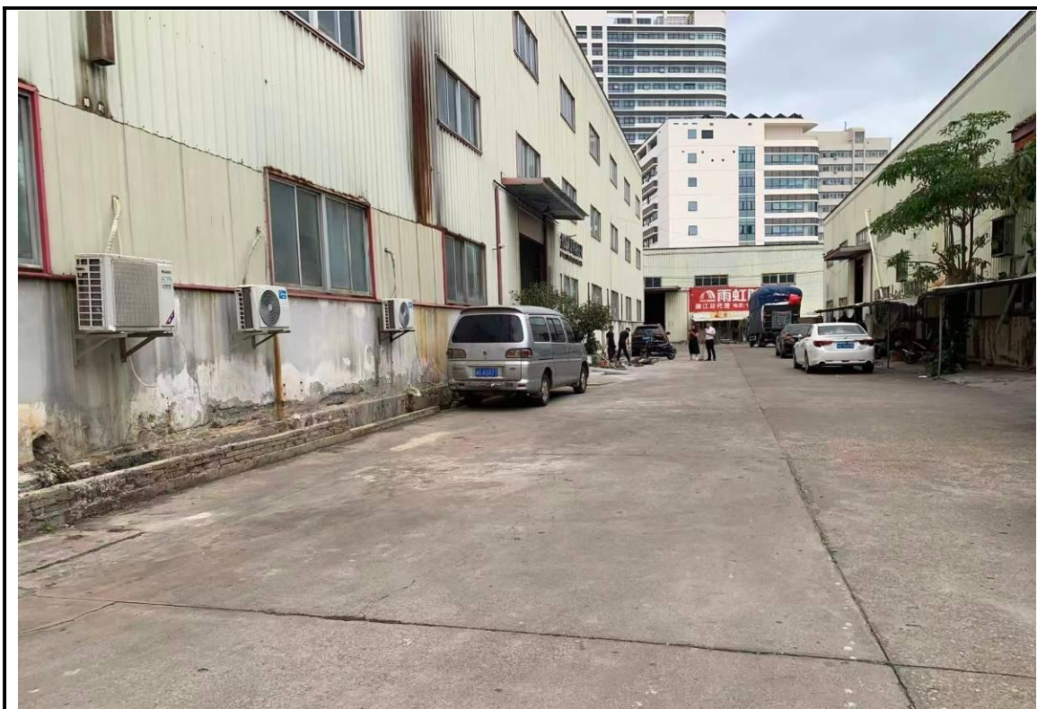
北地块项目建设区现状（二期）
