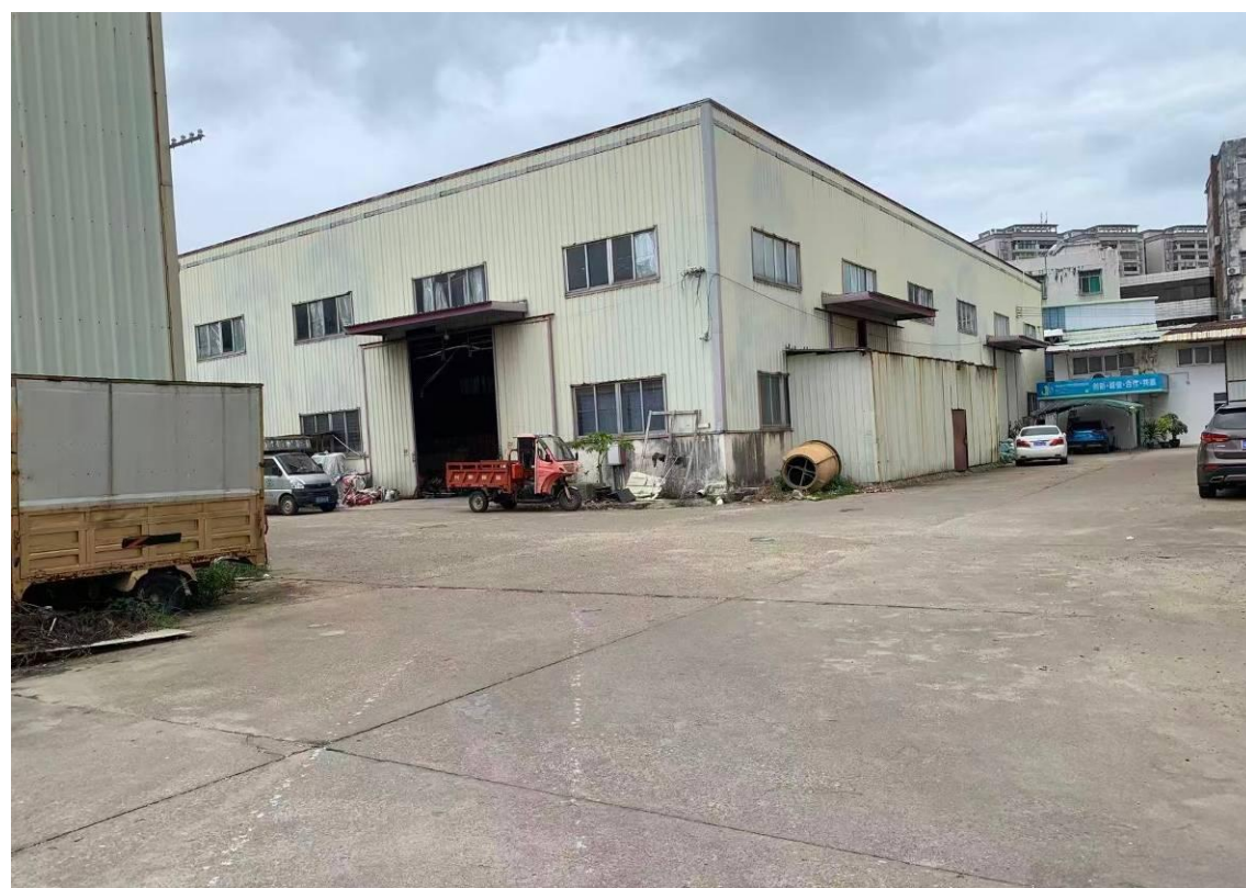
北地块项目建设区现状（二期）
