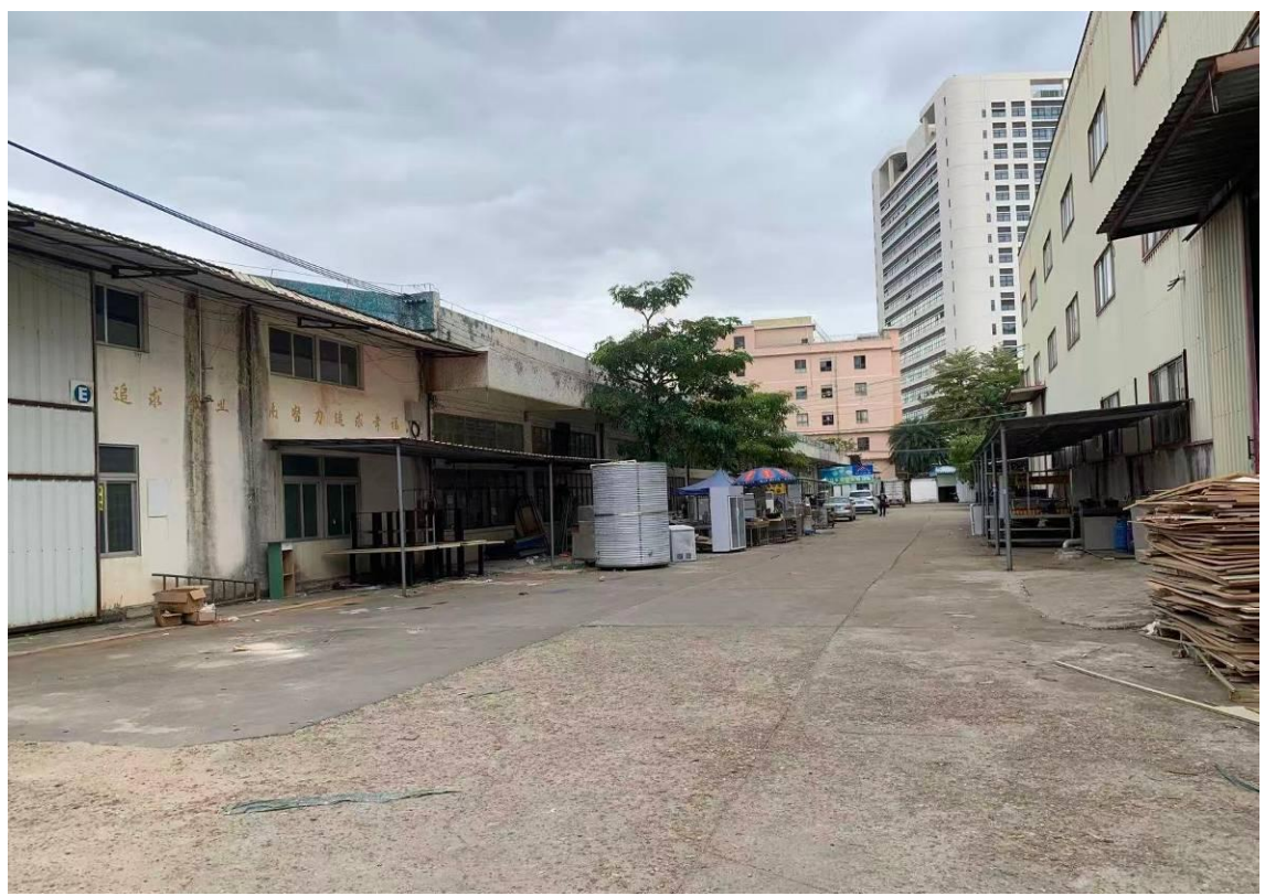
北地块项目建设区现状（二期）
