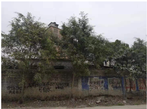
项目北侧长岭水泥厂现场照片
