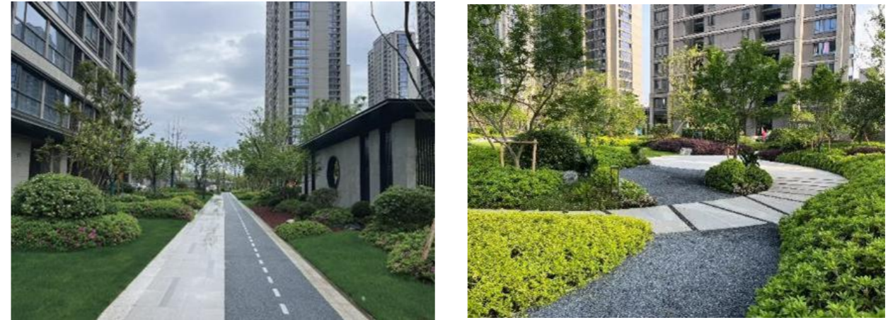
图 4.3-5 透水混凝土跑道及砾石铺装
