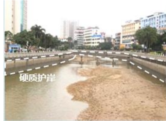
图 2.5-15 南桥河硬质护岸
