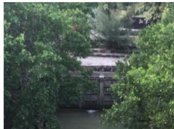
三号渠挡潮闸
