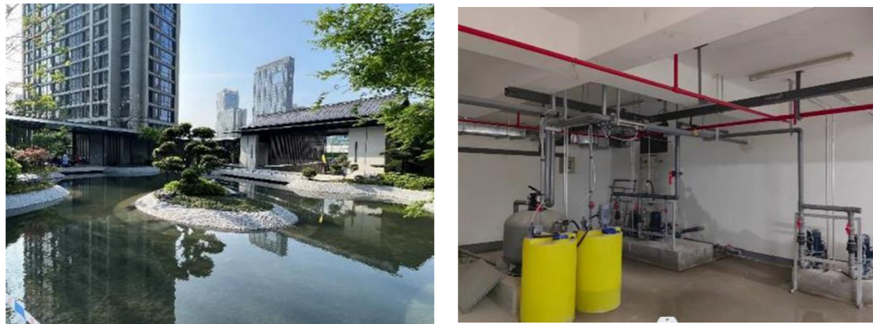
图 4.3-7 景观水池（左）雨水回收机房（右）
