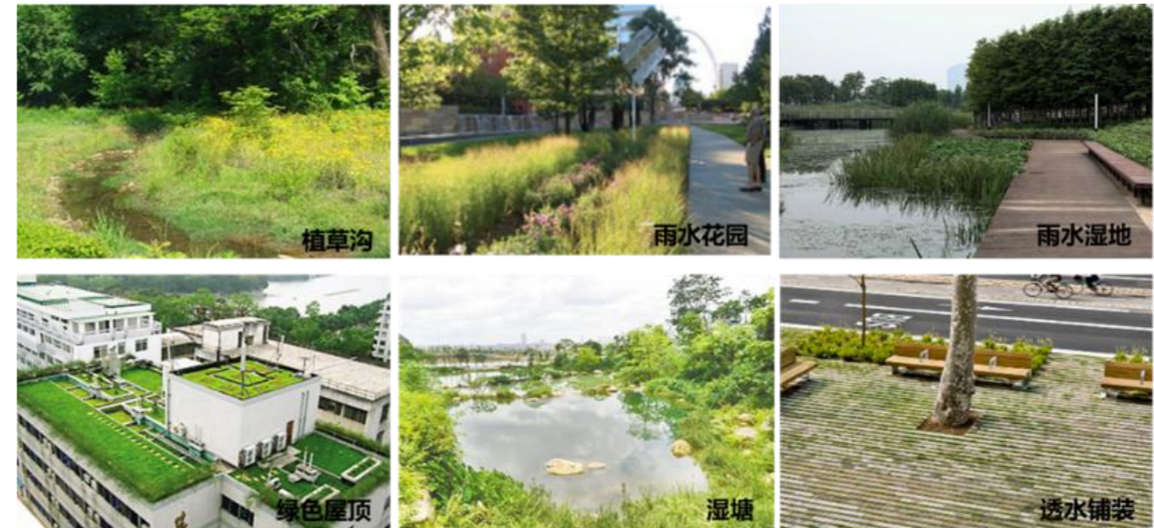
图 4.2-6 低影响开发设施示意图
