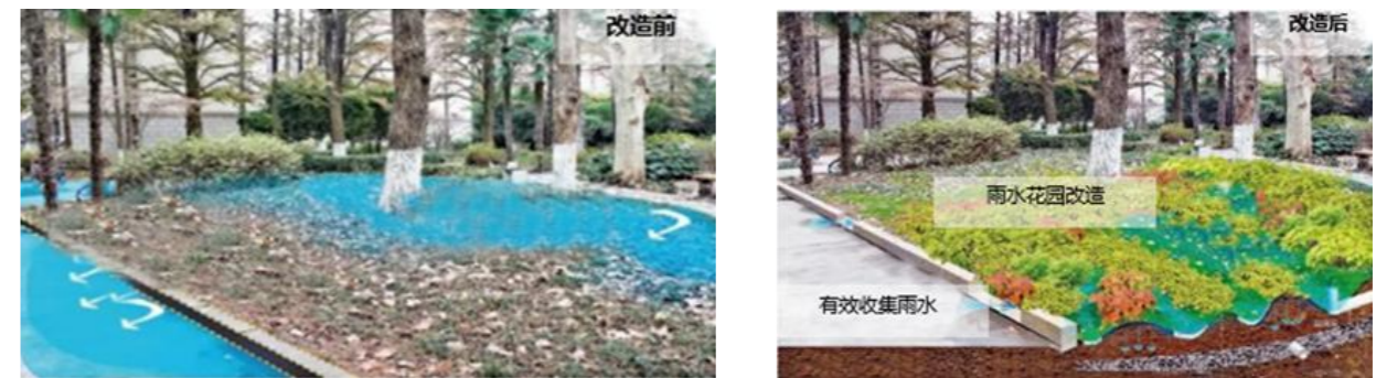
图 4.2-15 雨水滞留设施
