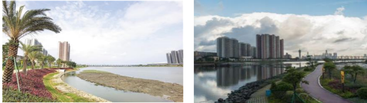
图 5.2-5 南调河综合治理工程
