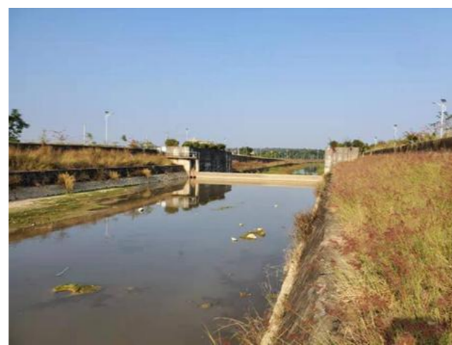
图 2.5-17 南柳河硬质护岸
