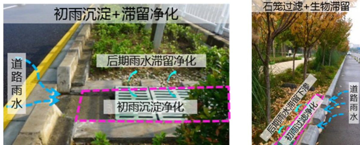
图 4.2-16 道路绿化带海绵化改造示意图
