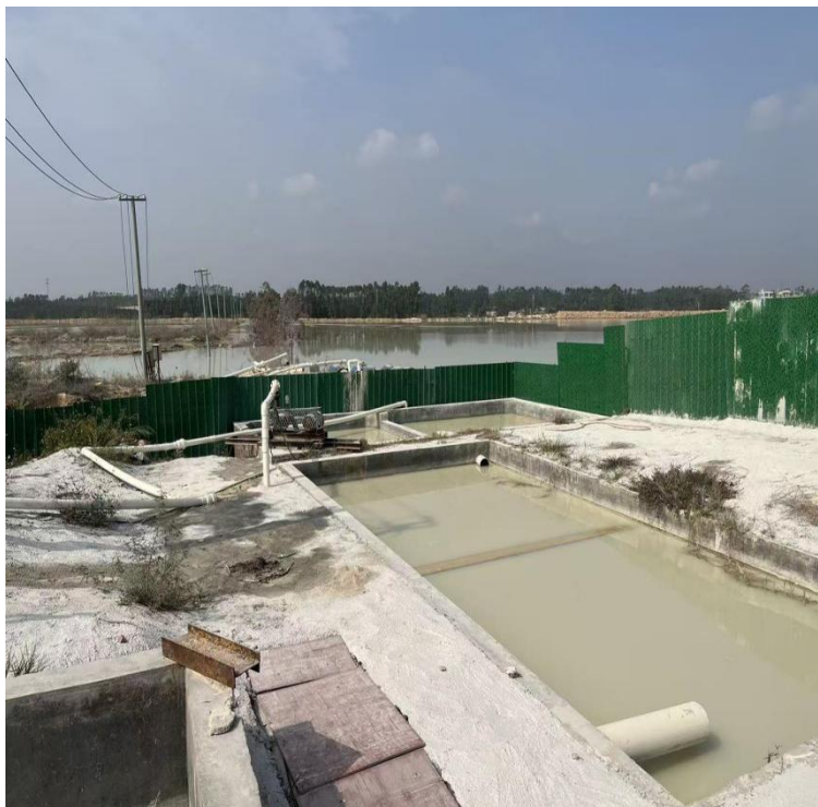
(循环利用区沉沙池) (循环利用区排水口)
