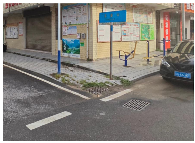
沉沙井及排水管网现状
