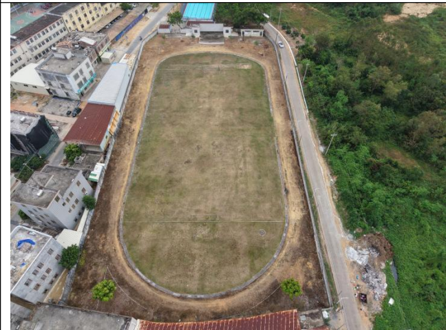
球场修缮及健体设施建设工程
