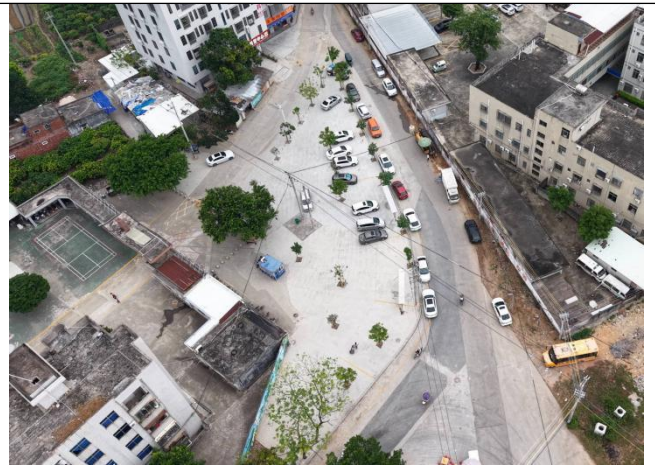
球场修缮及健体设施建设工程
