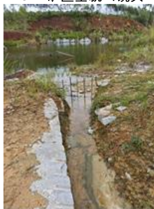
图 2.1-5 旧采坑西南侧排水沟
