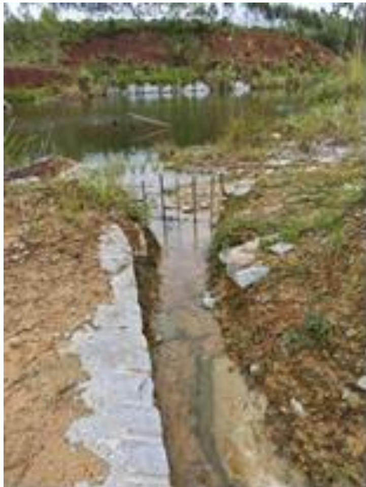
照片 4 采坑西南侧排水沟
