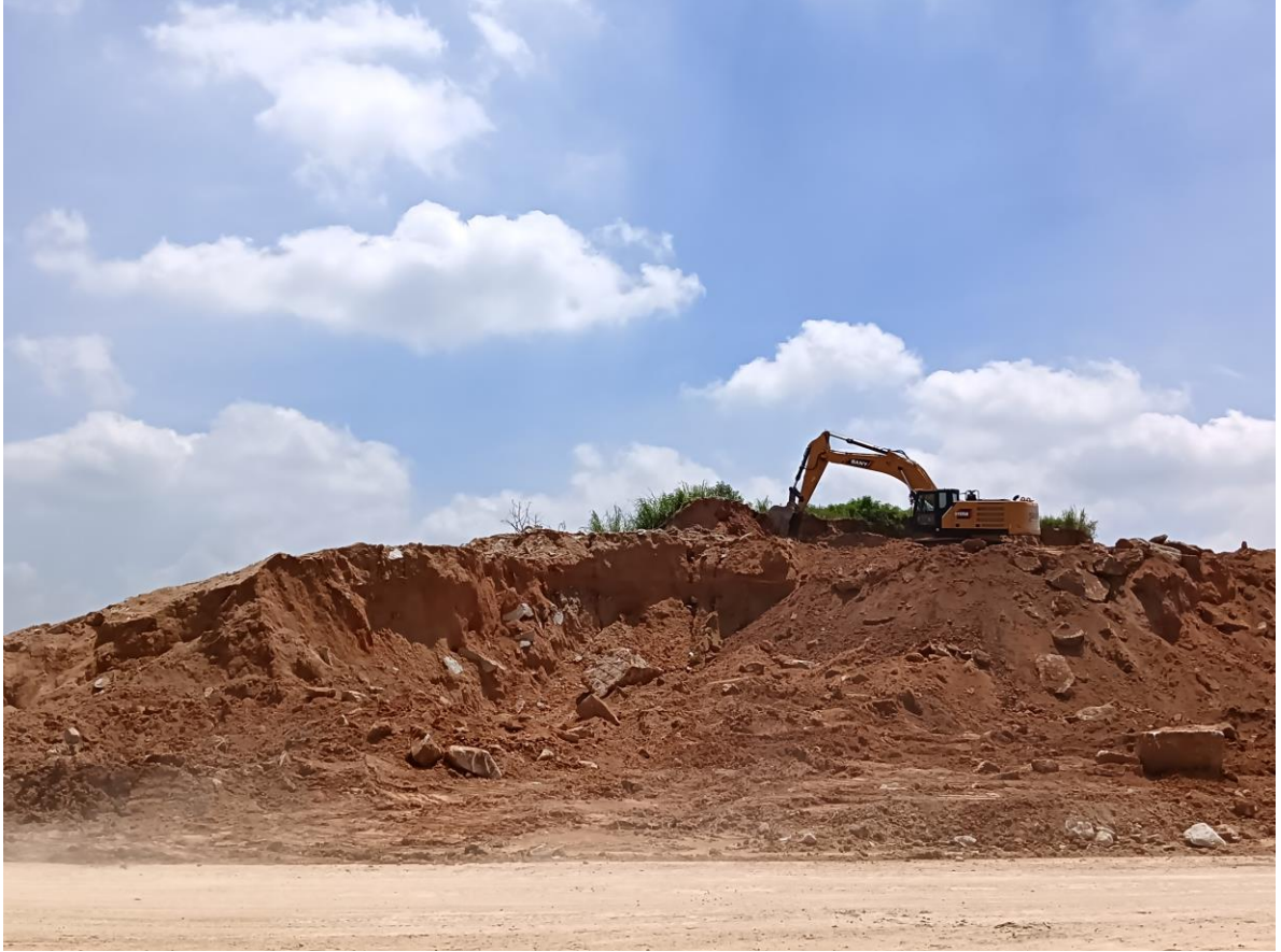
照片 16 场地平整作业 (25.6.24)
