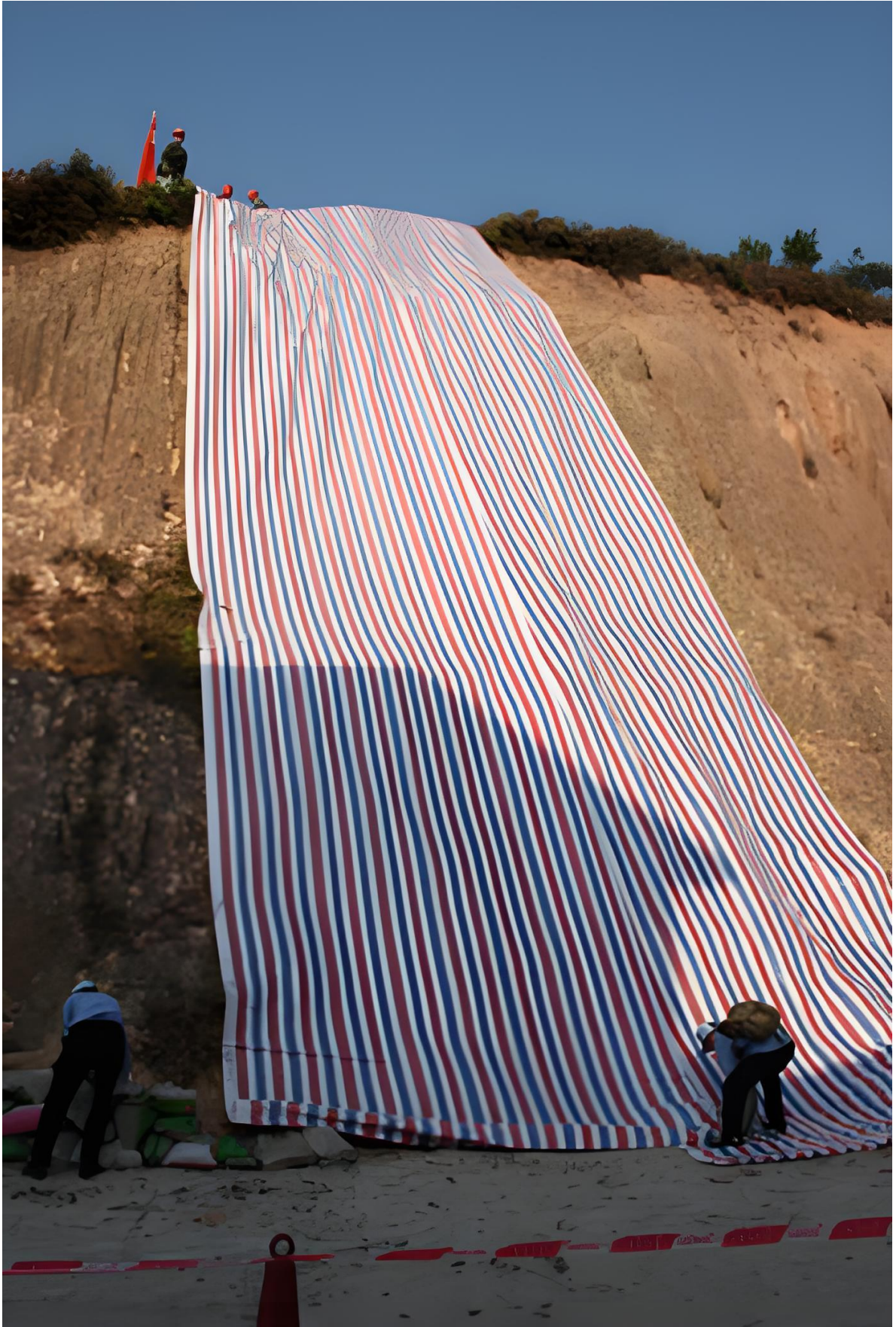
照片 15 边坡彩条布覆盖
