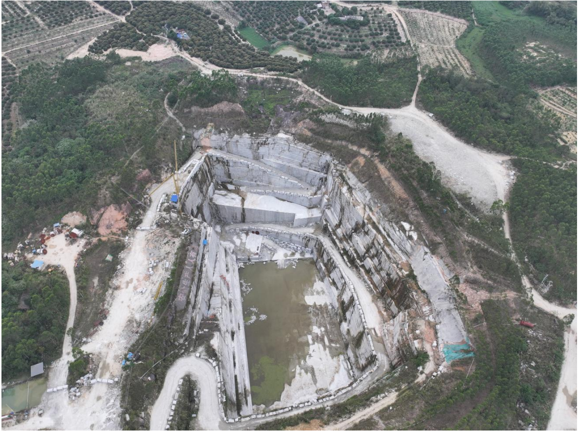
照片 5 原中汇矿区采矿坑航拍图 (3/4)
