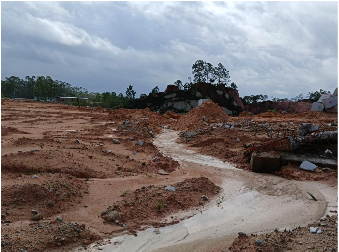
照片 17 临时土质排水沟 (25.6.24)
