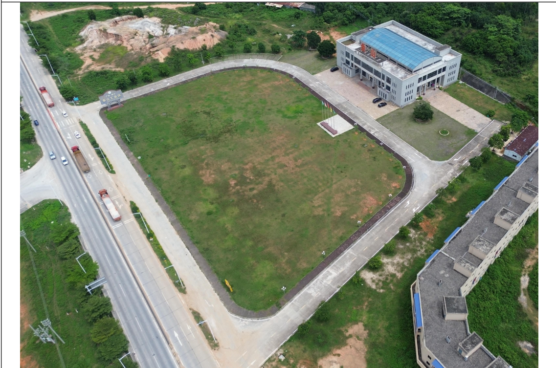
JSB3-28、JSB3-29 地块现状（建成区生产建设区）
