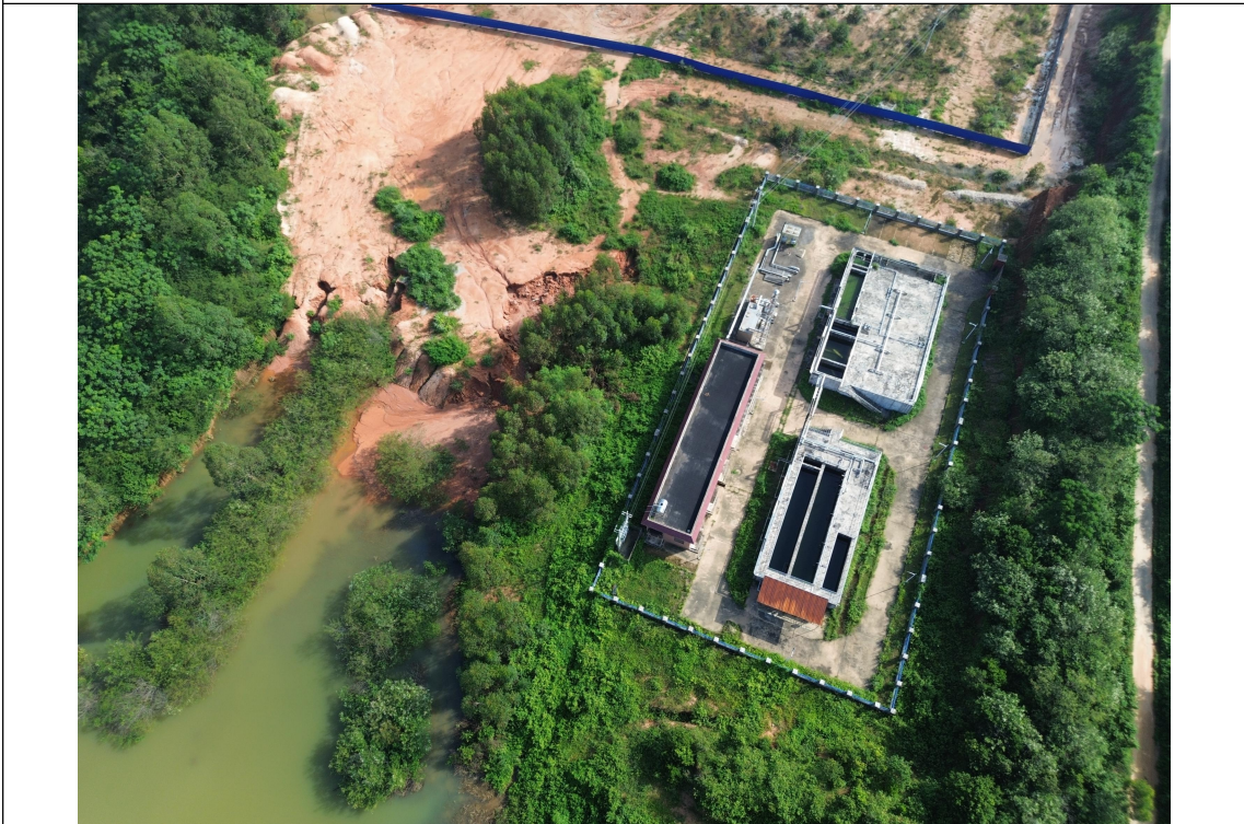
污水处理厂升级改造工程现状（在建区生产建设区）
