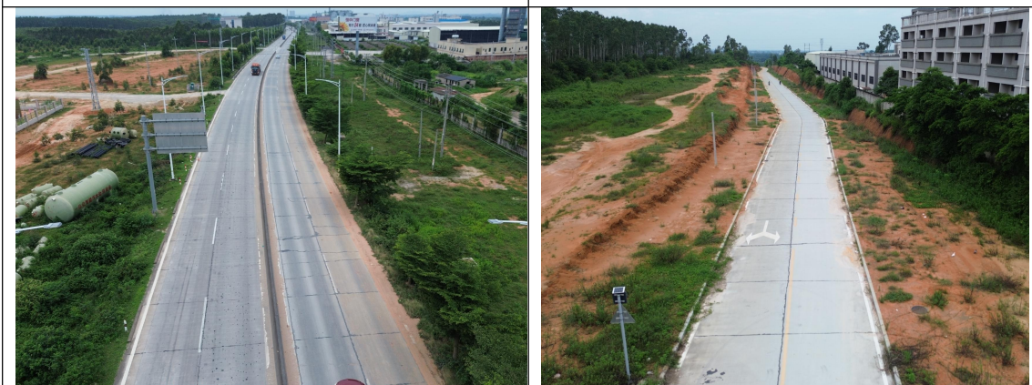
项目区内 G228 国道现状
