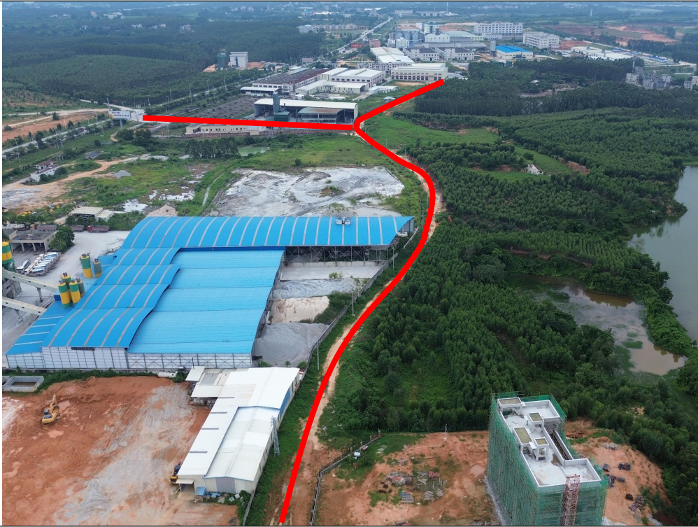
经二路北侧东南向支路三及周边道路现状（在建区道路工程区）
