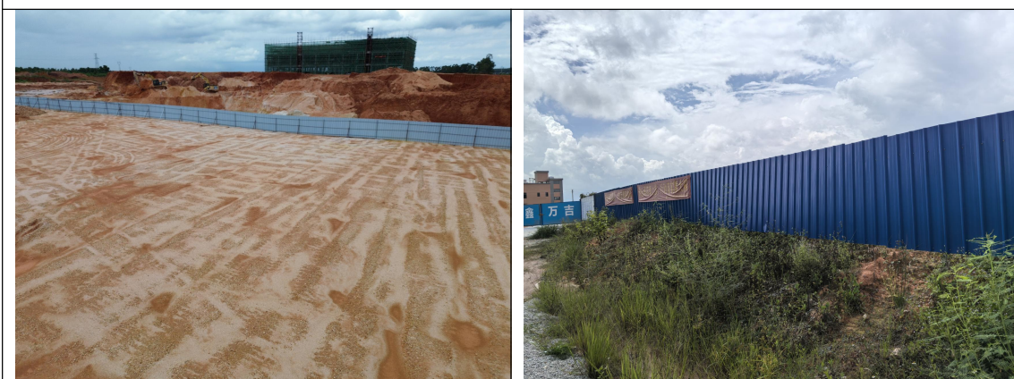
JSC5-02 地块施工围蔽现状
