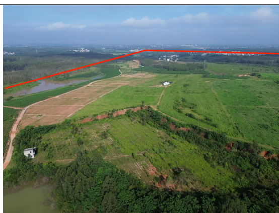
园区南侧地块现状
