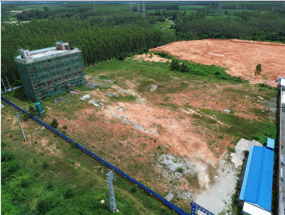
JSB2-09 地块南侧现状（建成区场地平整区）
