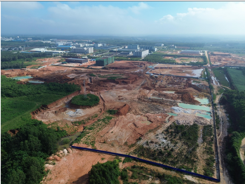
JSC5-11 地块现状（在建区场地平整区）
