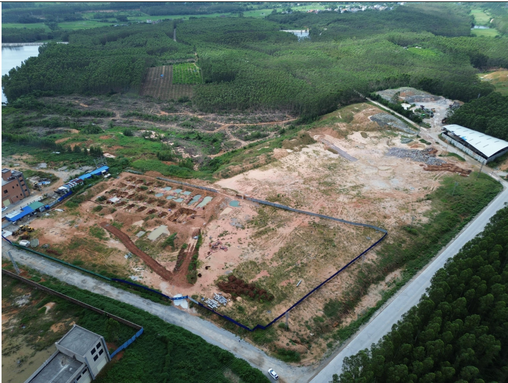
JSC1-04、JSC1-05 地块现状（在建区场地平整区）
