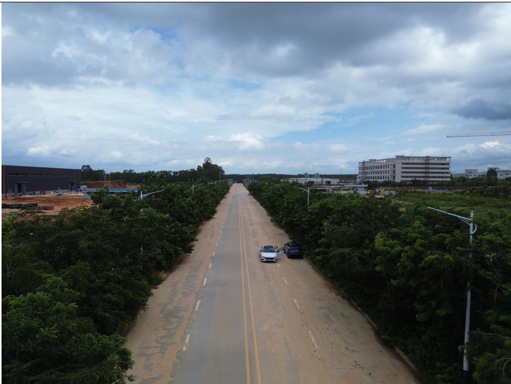
园区内已建成经二路现状（建成区道路工程区）
