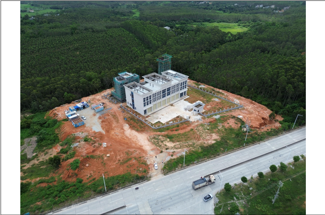
金山消防站建设现状（在建区生产建设区）
