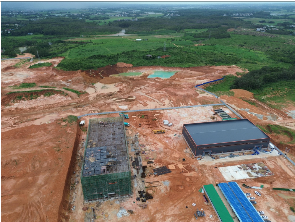
JSC5-01 地块现状（在建区场地平整区）
