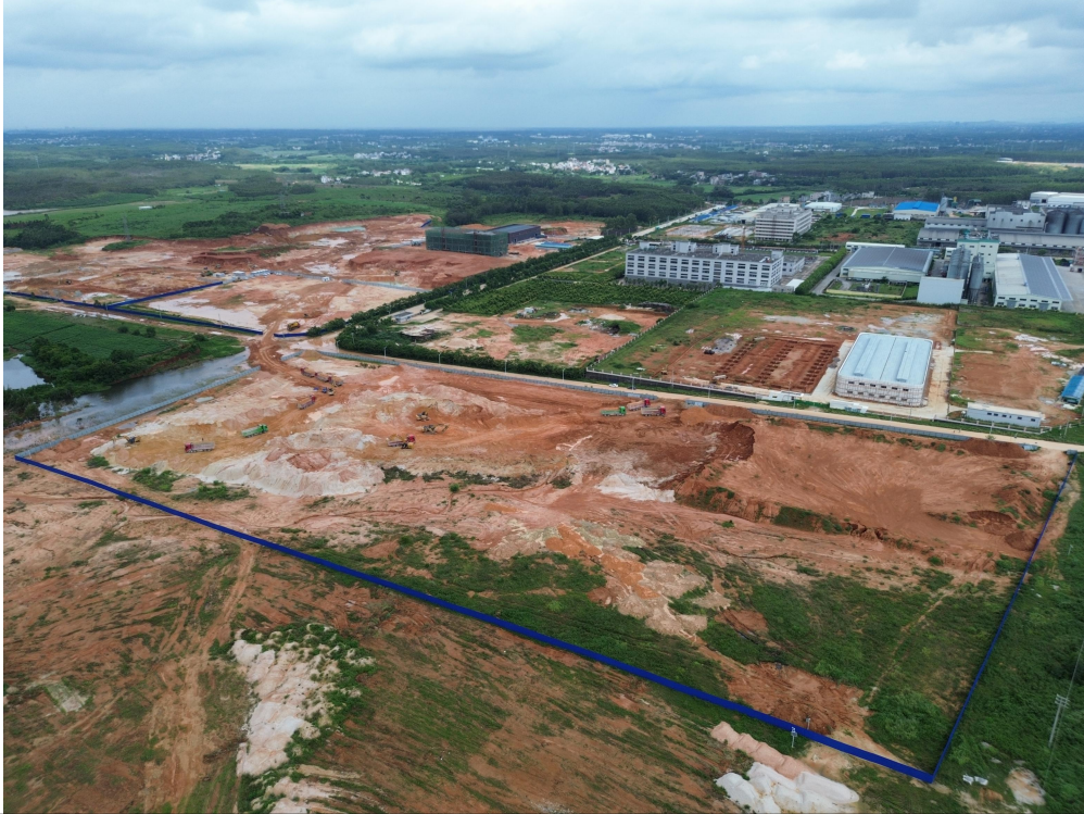
JSC2-03 地块现状（在建区场地平整区）
