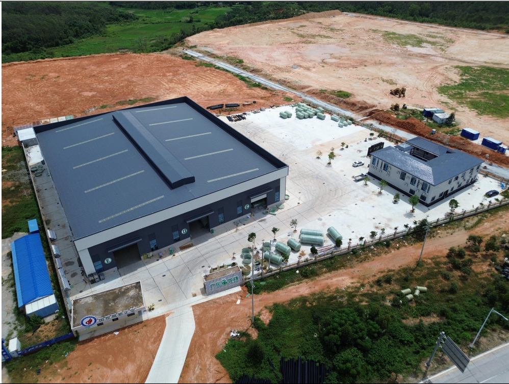
JSB2-11 地块南侧现状（建成区场地平整区）
