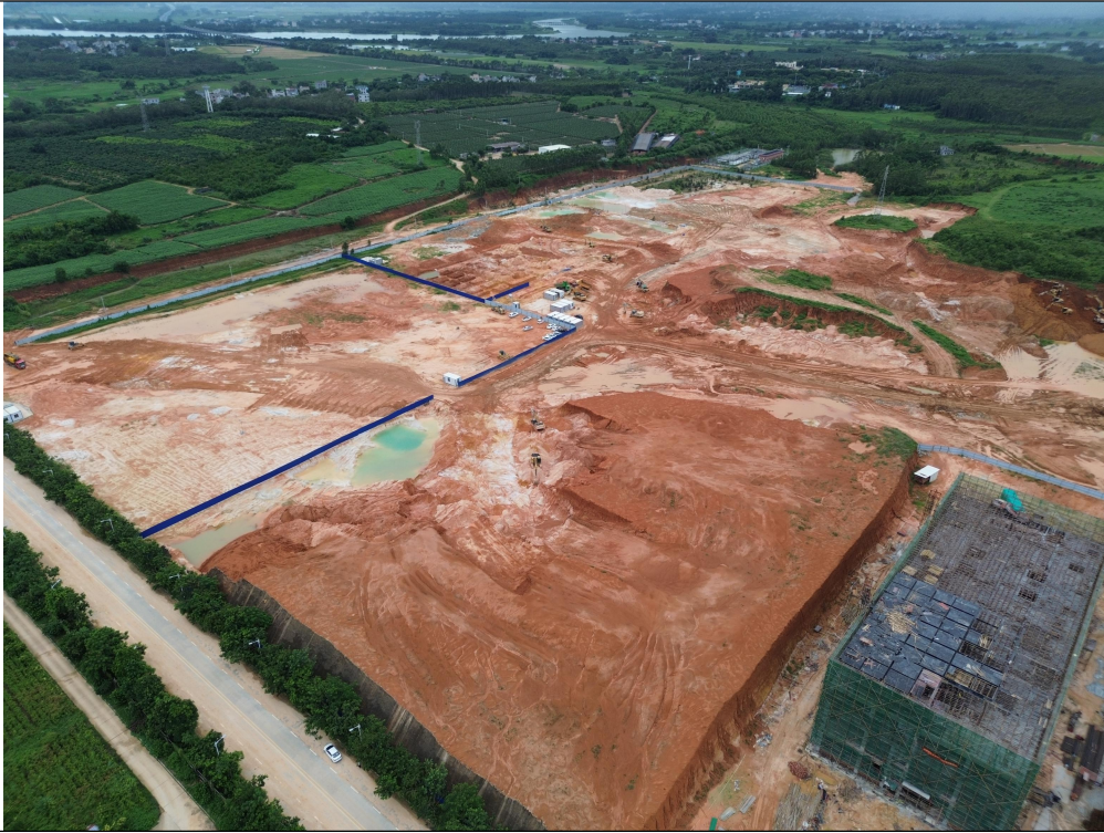
JSC5-02 地块现状（在建区场地平整区）
