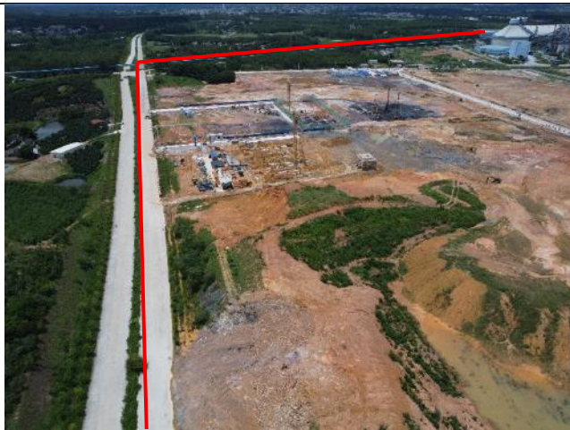
罗州大道西延伸线场地现状
