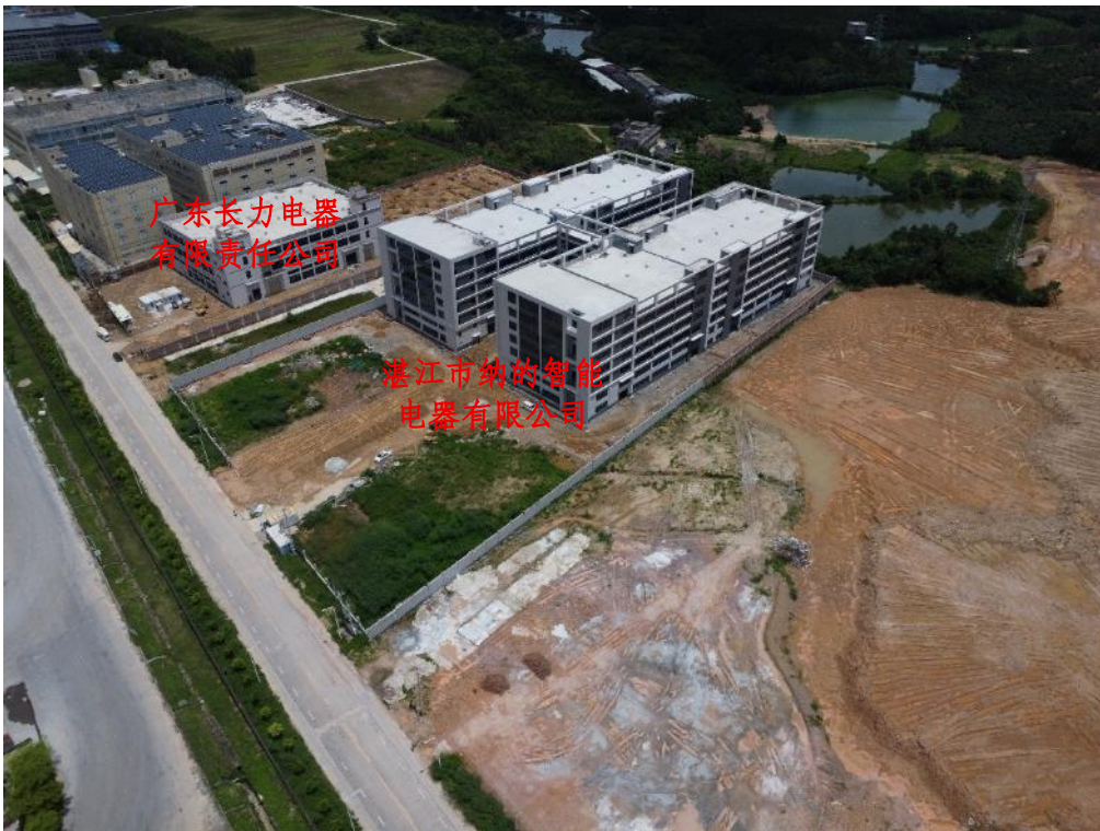
图 2-35 华润混凝土（廉江）有限公司东南侧厂房建设场地现状影像图
