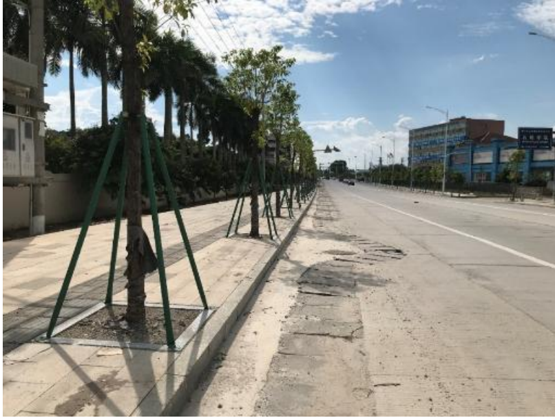
图 2-28 287 省道旁排水边沟和污水井
