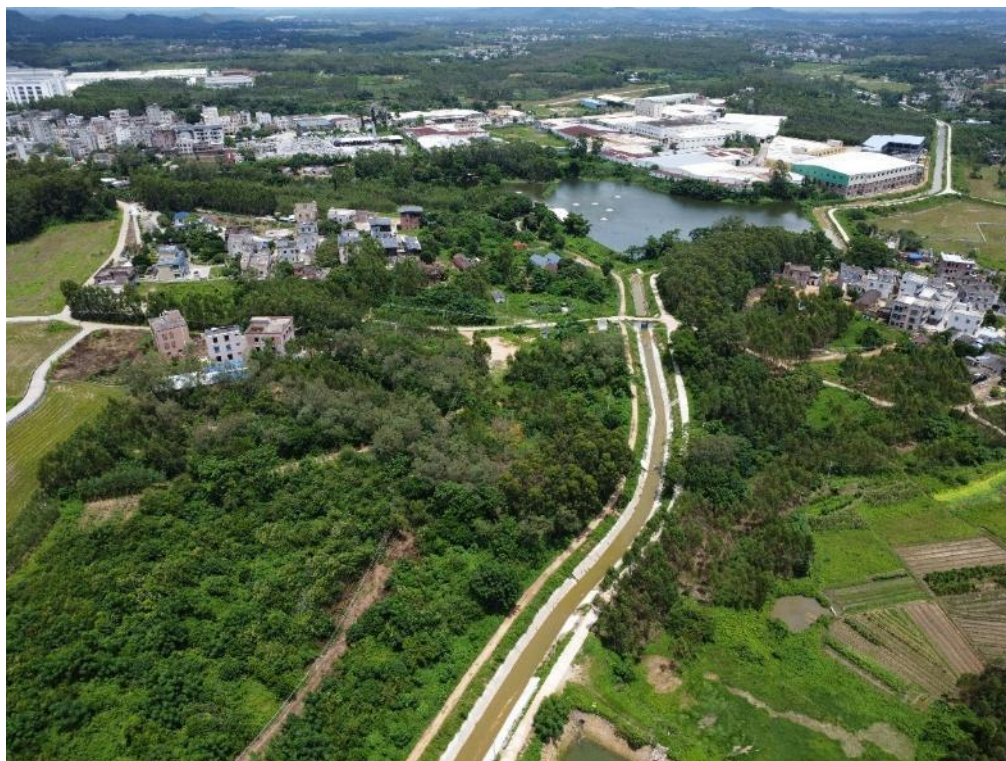
图 2-39 廉江市武陵水库灌区续建配套与节水改造工程场地现状影像图
