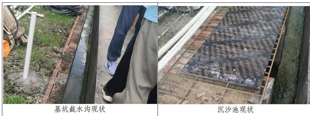
图 3-1 已布设水土保持措施现状
