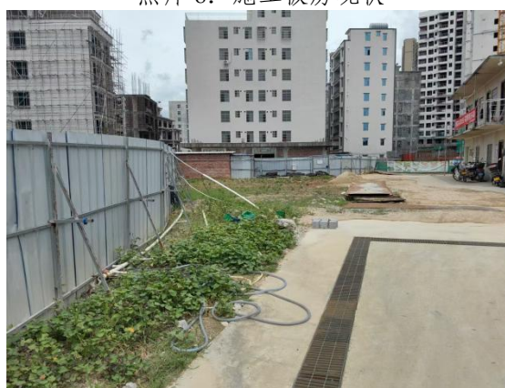
照片 10: 施工营造用地空地现状
