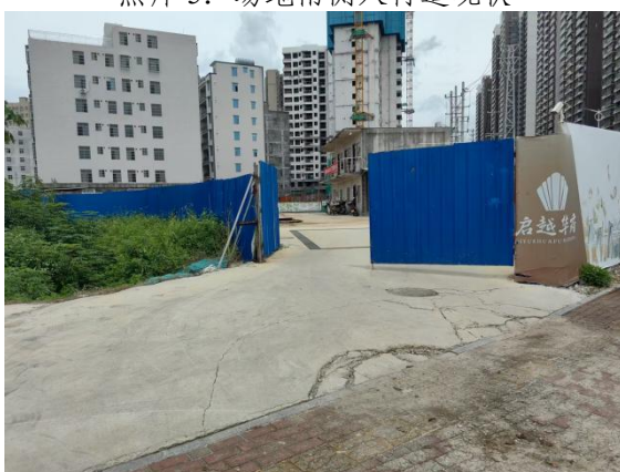
照片 7: 场地西侧出入现状
