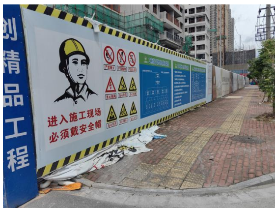
照片 5: 场地南侧人行道现状
