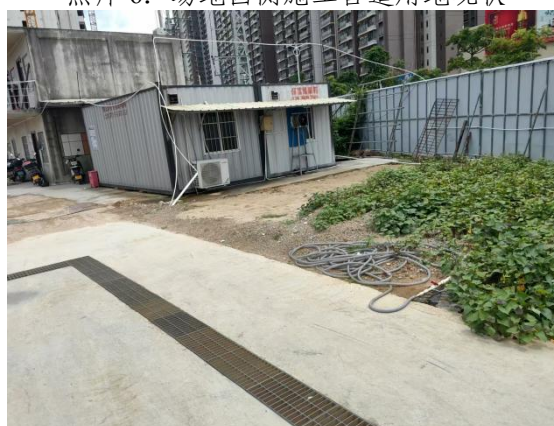
照片 8: 施工板房现状
