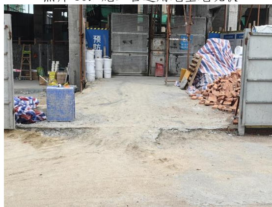
照片 12: 场地东侧施工出入口现状
