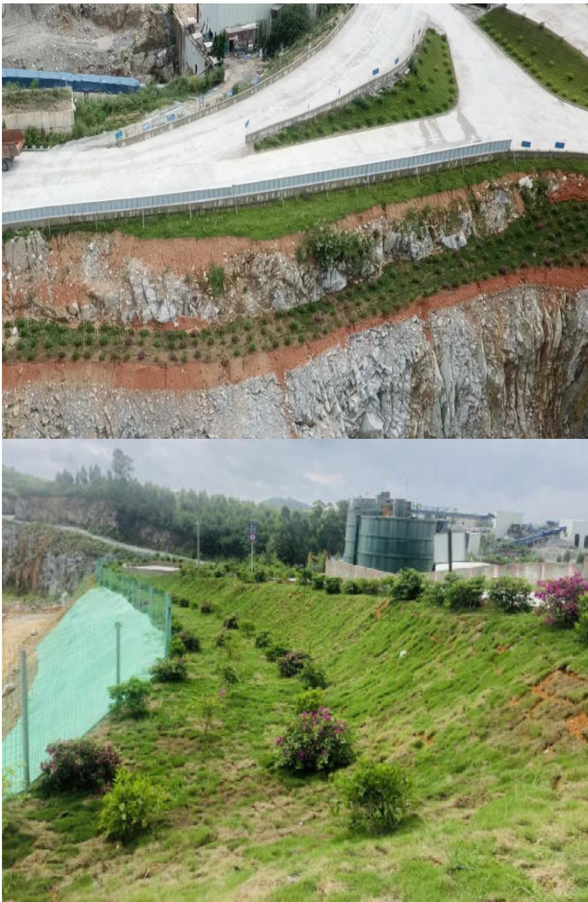
案例照片 2 对已形成台阶进行复垦绿化治理
