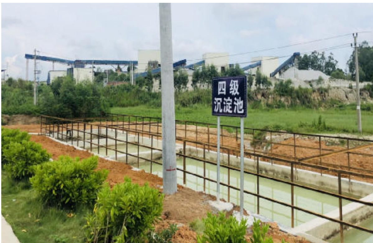
案例照片 4 矿区污水沉淀池
