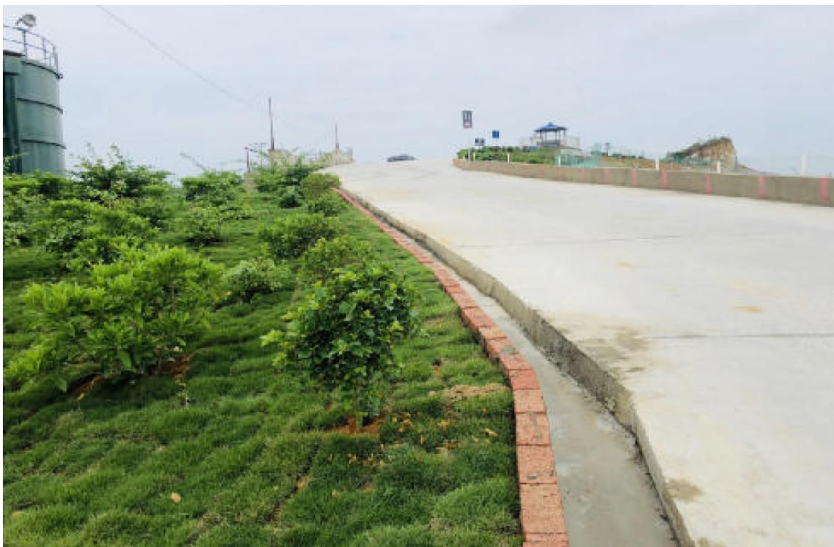
案例照片 3 矿区周围设有截排水沟
