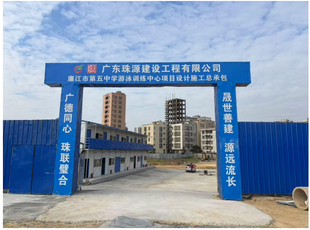
项目场地出入口
