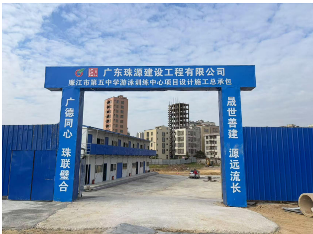
项目场地出入口
