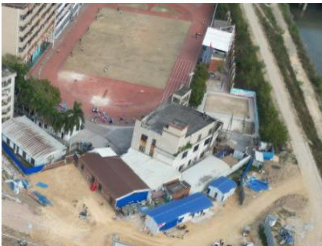
项目东面为廉江第五中学的操场
