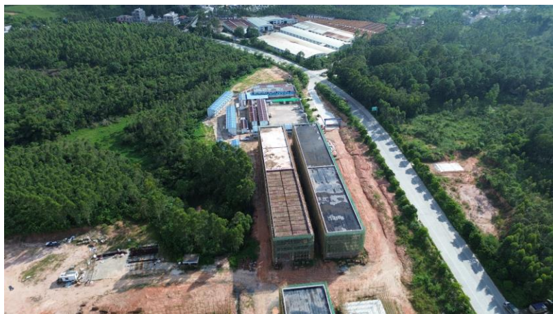
在建项目旁布设的施工临建区（2024 年 10 月拍摄）
