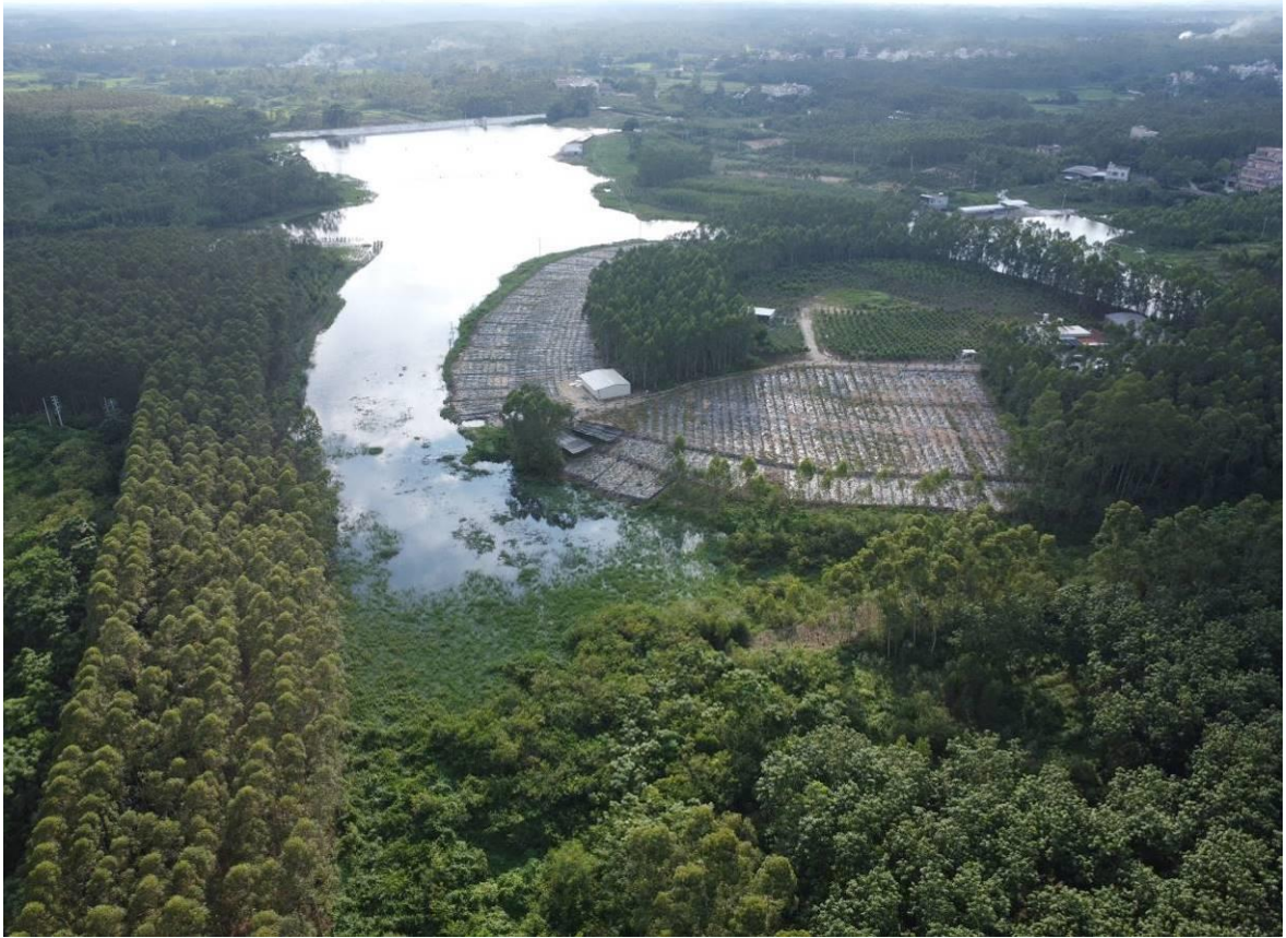
图 2-2 火烧叉水库现状航拍图
