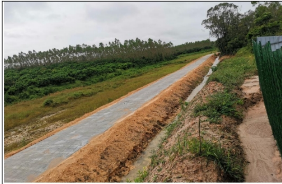
照片5 工业场地西侧排水沟
