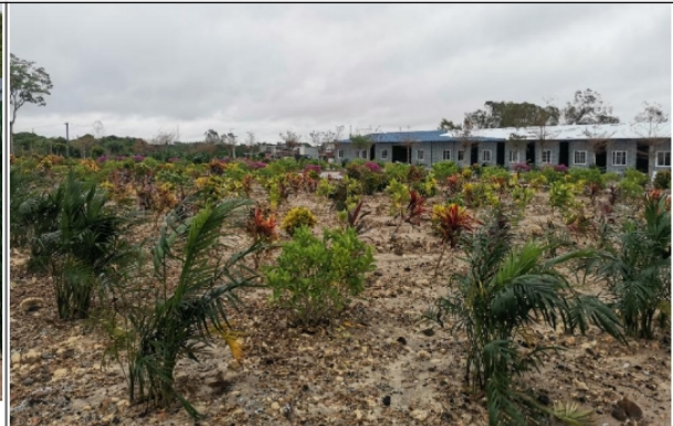
照片6 现状综合服务区2
