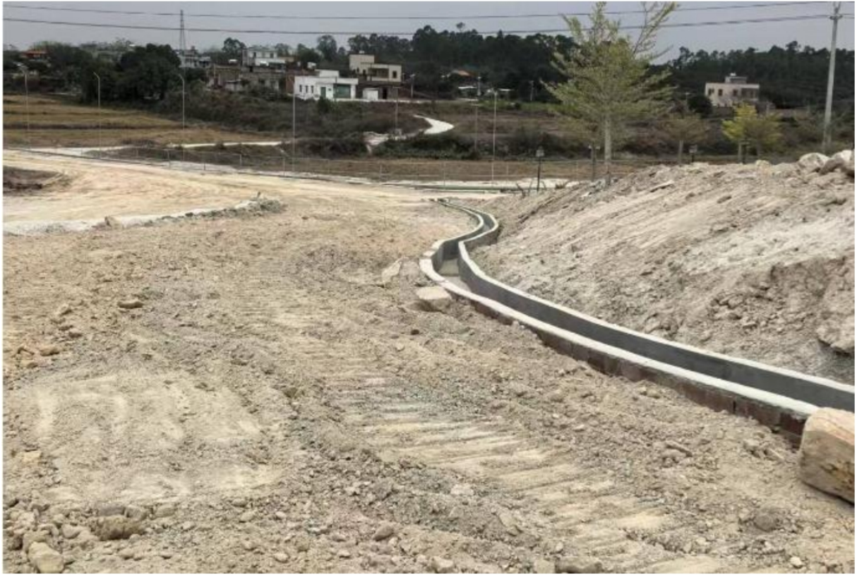
矿区西侧截排水沟（摄于 2025.3.3）
