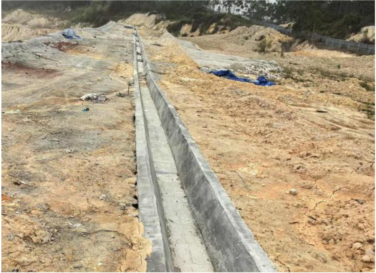
矿区北侧截排水沟 1（摄于 2025.3.3）
