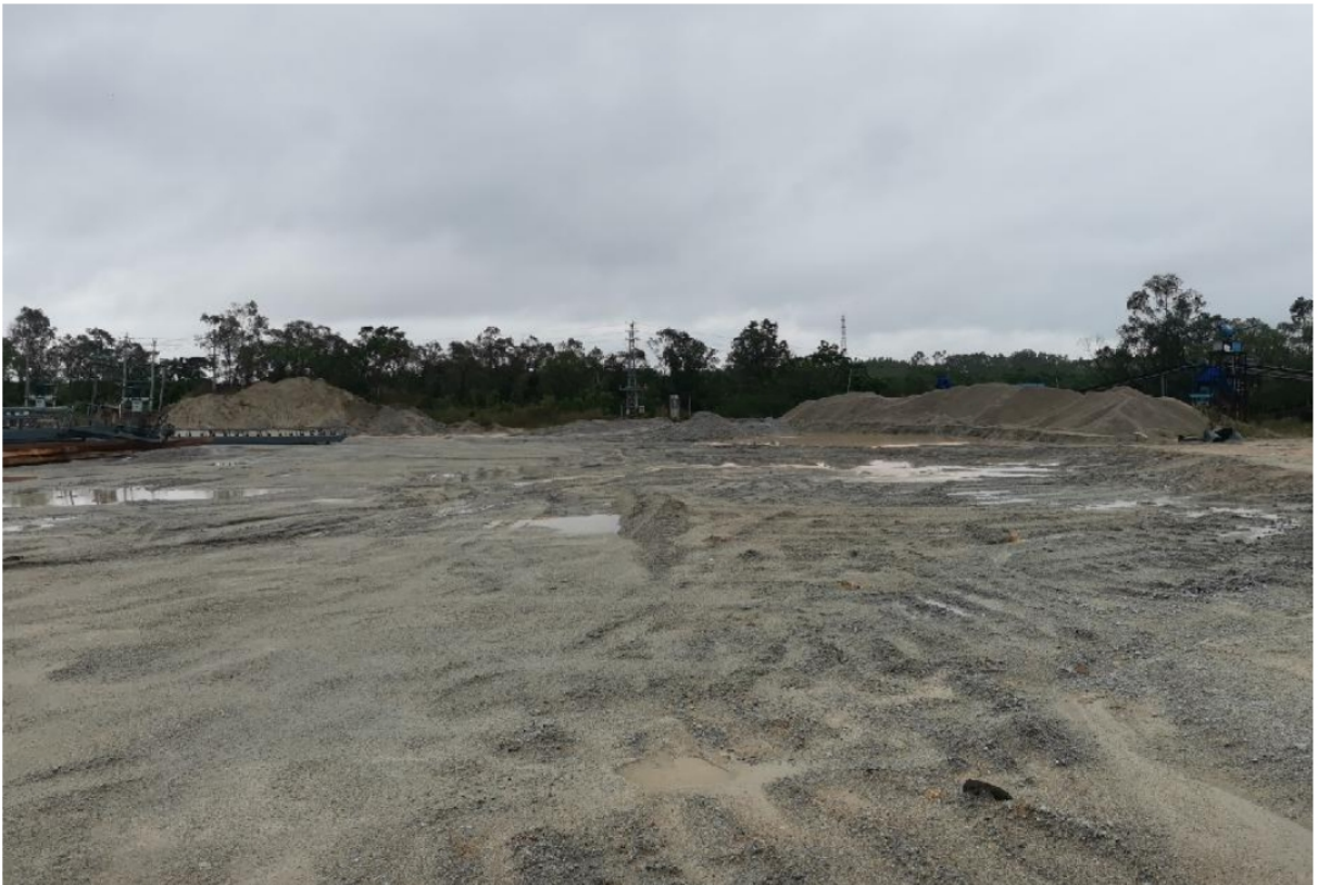
现状碎石加工区
