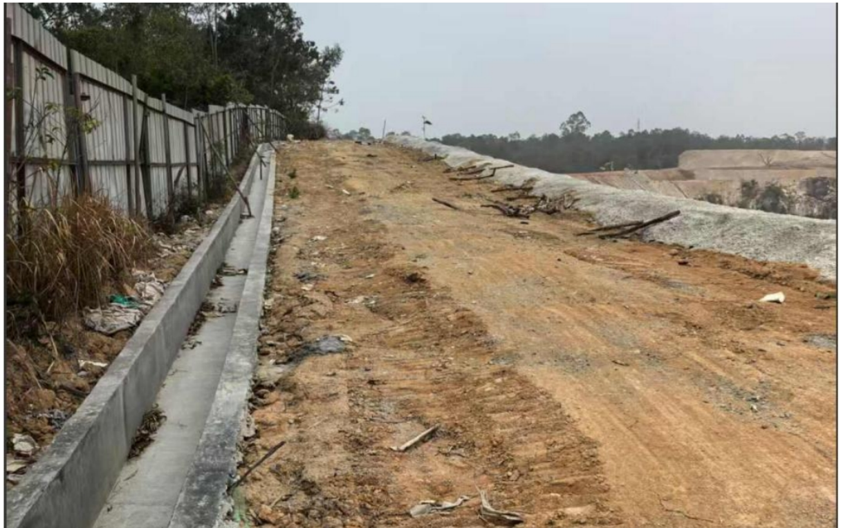
矿区北侧截排水沟 2（摄于 2025.3.3）
