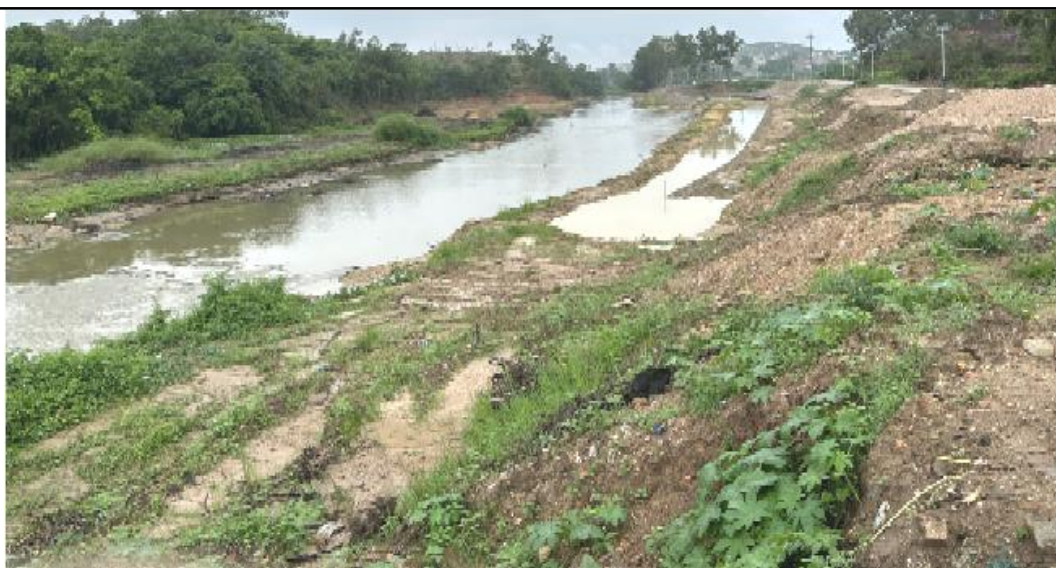
图 2-8 龙潭河现状照片
