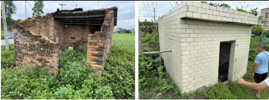
图 2-14 泵站现状照片
