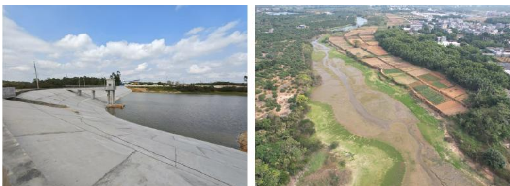
图 2-1 黄盆山水库现状照片
