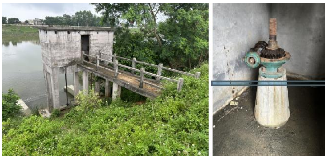
图 2-18 东山涵闸现状照片
