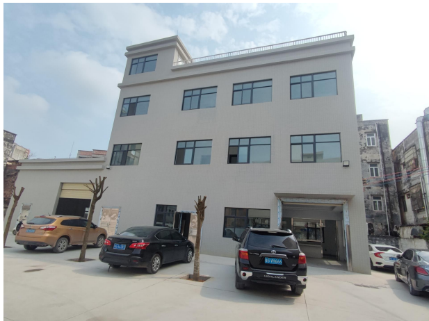
运维中心现状图
