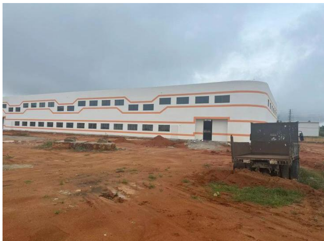
主体建筑区现状
