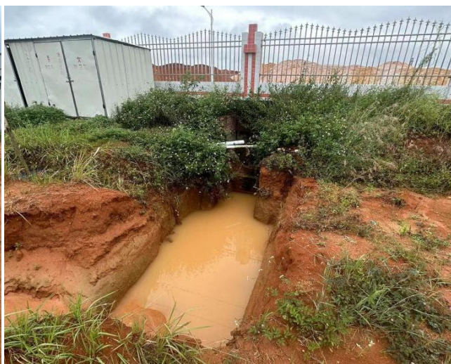
临时沉沙池现状
