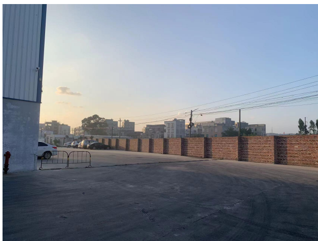
项目区围墙现状
