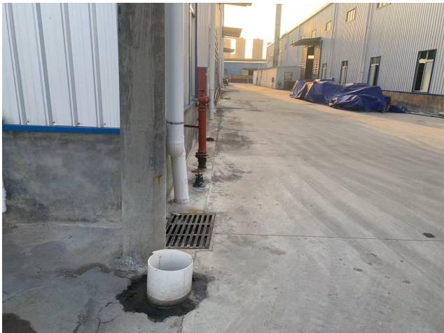
项目区雨水管网现状
