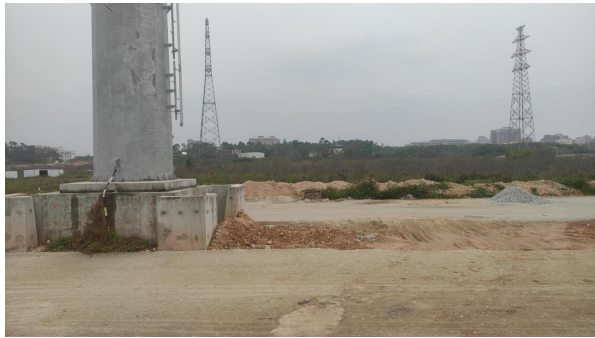
项目北侧（在建道路）
