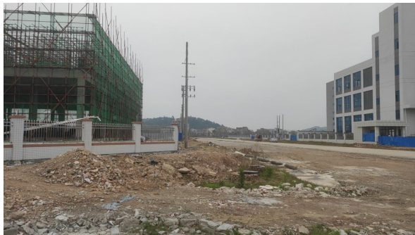
项目西侧（在建道路）
