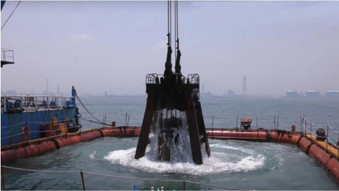
图 8.2.3-5 抓斗船包围防污帘示意图
