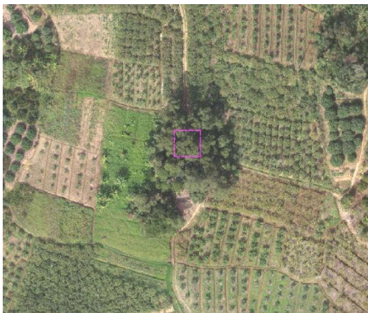
J5 塔基位置航拍图
