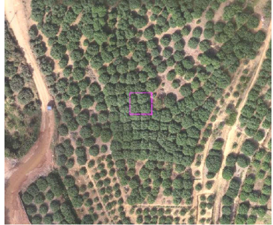
J2 塔基位置航拍图
