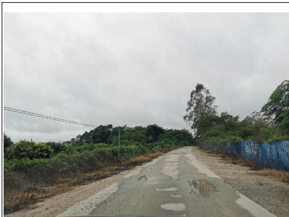
照片1 进场道路现状
