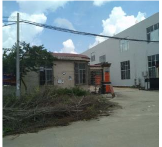
项目北侧现场图片
