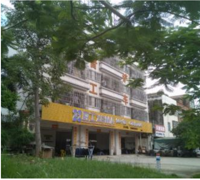
项目东侧现场图片
