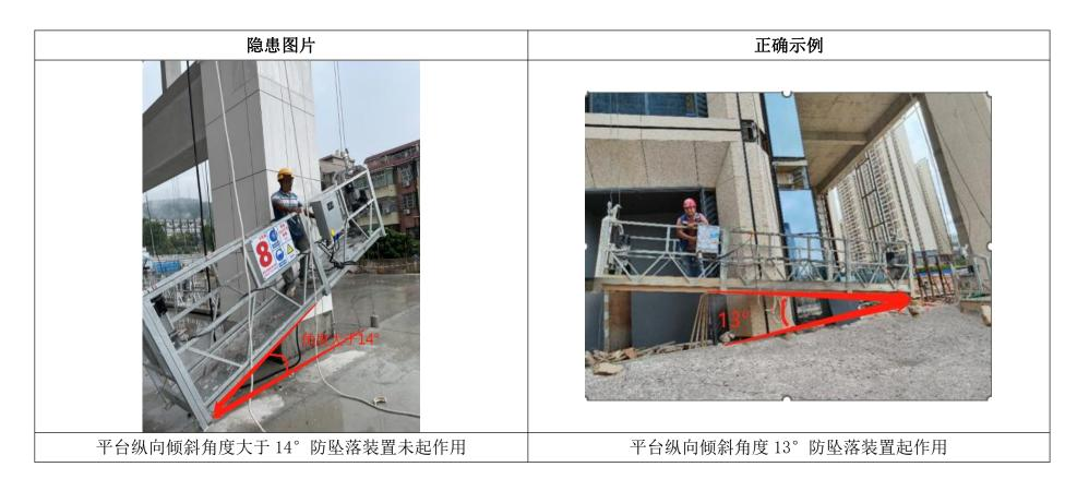
**隐患问题:** 平台纵向倾斜角度大于 14° 防坠落装置未起作用。 **风险分析:** 使用过程中,平台失控,导致吊篮发生倾覆失落。
