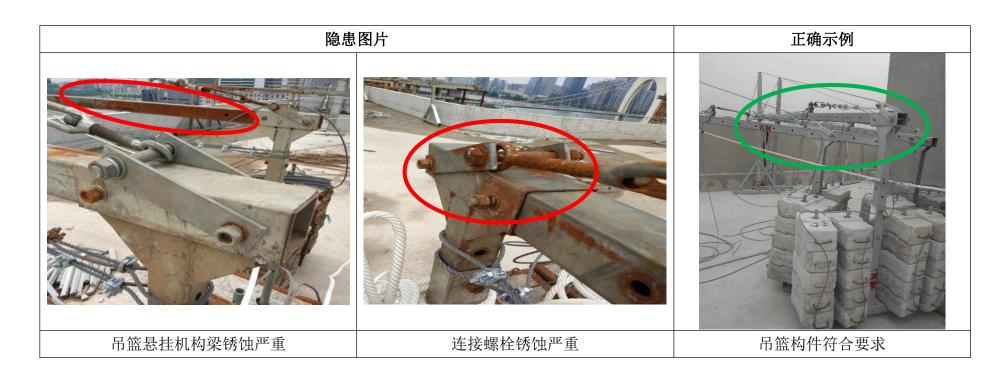
隐患问题: 吊篮构件锈蚀严重。
