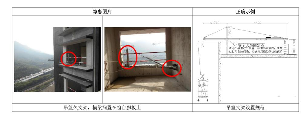
隐患问题: 吊篮前支架缺失,横梁直接或垫木方搁置在窗台飘板上。
