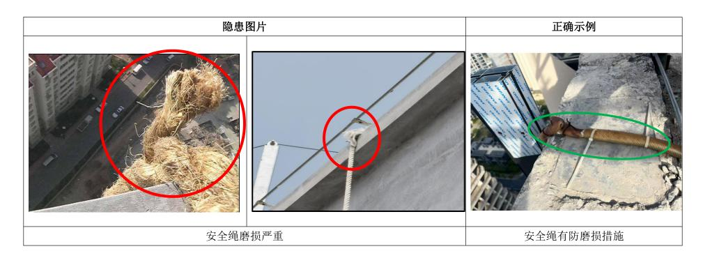
隐患问题:安全绳与女儿墙或建筑物结构的转角接触处磨损严重。
